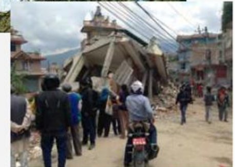
Eingestürzter Neubau in Kapan
